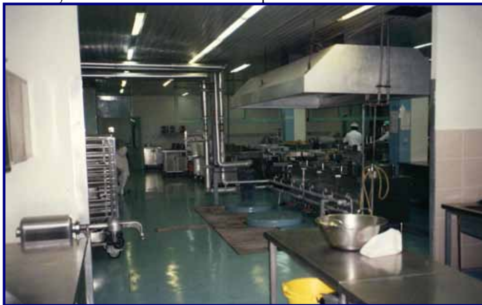
Slika 15. Dobro izvedeni. podovi.
