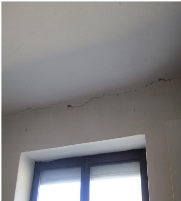
*Slika 2.67 Pukotine završnog sloja na spoju spuštenog stropa i zida*
