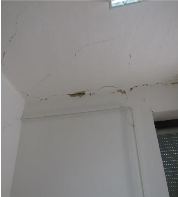
*Slika 2.89 Pukotine u žbuci i oštećenje završnog sloja zida*
