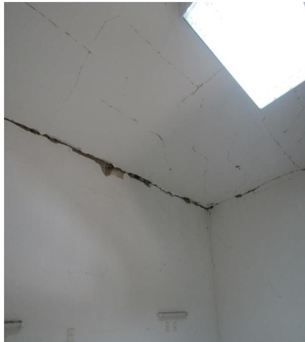
*Slika 2.108 Pukotine na spoju zida i stropa*
