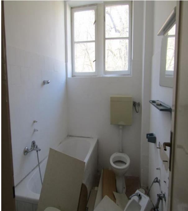
*Slika 2.69 Pukotine u žbuci na spoju zidova i odlamanje pločica*
